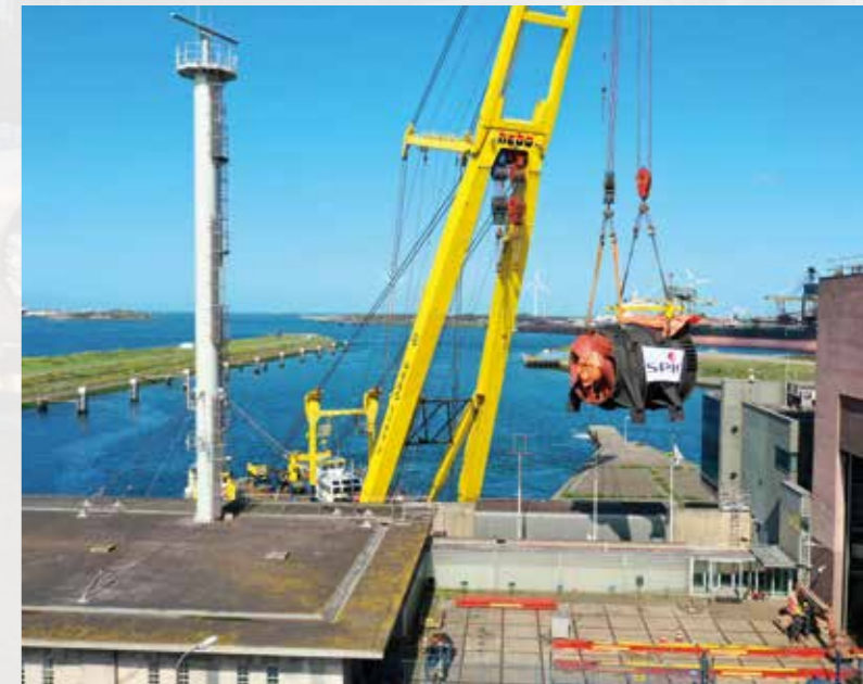
De defecte pomp is uitgebouwd en wordt weggetakeld en naar Amsterdam getransporteerd, waar de pomp in een werkplaats hersteld zal worden
