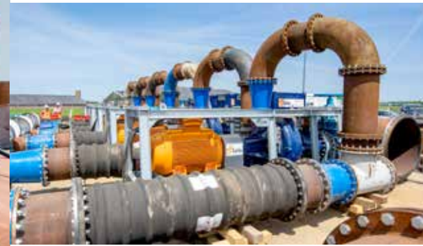
Het zuig-manifold van de RWA pompen uitgevoerd in staal Ø1200mm.
